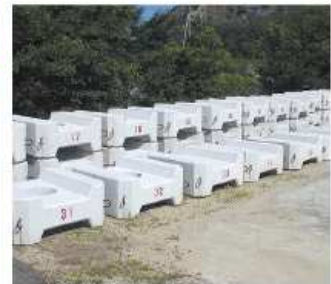
④型枠脱型
