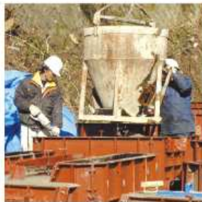
②コンクリート打設
