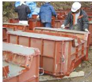
③コテ均し、養生
