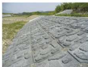
連結部碎石処理
