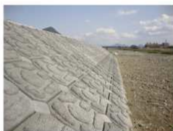
連結部着色コンクリート処理
