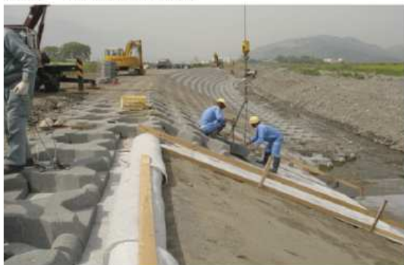
天端・法面部施工状況
