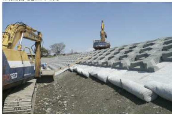
法面部施工状況
