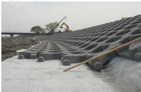
垂部施工状況
