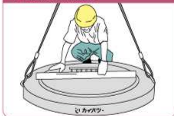
4 直壁と斜壁の据付
