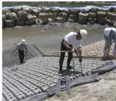
⑤ アンカーピン打設
