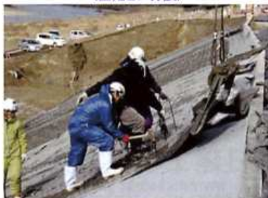
ブロックマット設置 （固定ピン打設）
