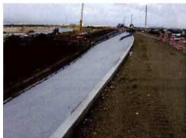
遮水シート敷設
