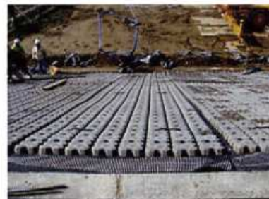
ブロックマット敷設完了
