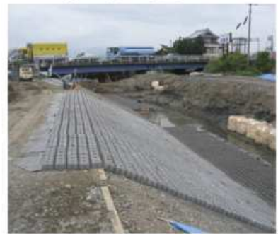
⑥ 施工完了
