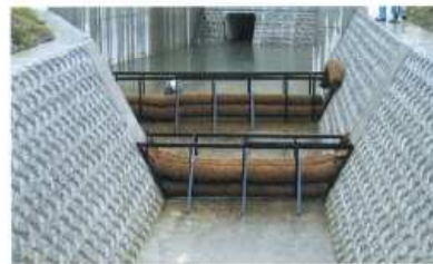
コンクリート護岸の都市河川での使用
