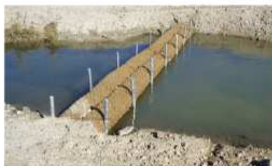
河川へ流出する手前での濁水対策
