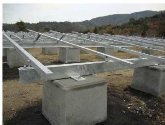
インサート固定状況
