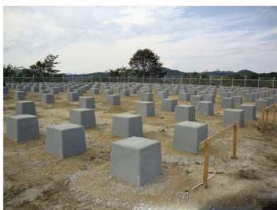
基礎ブロック設置状況
