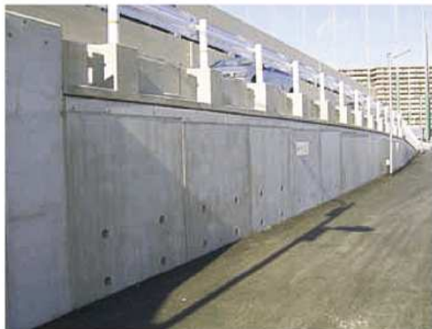
プレキャストL型擁壁直上
