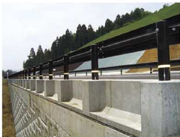
補強土壁直上
