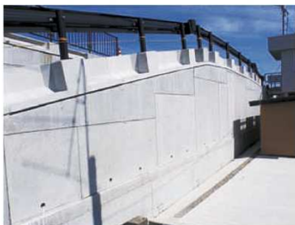
勾配変化部設置
