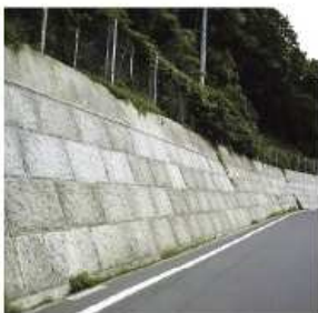
道路改良工事
